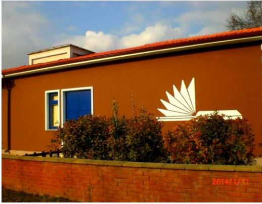
(60) Kütüphane Dış Duvar Süslemesi
