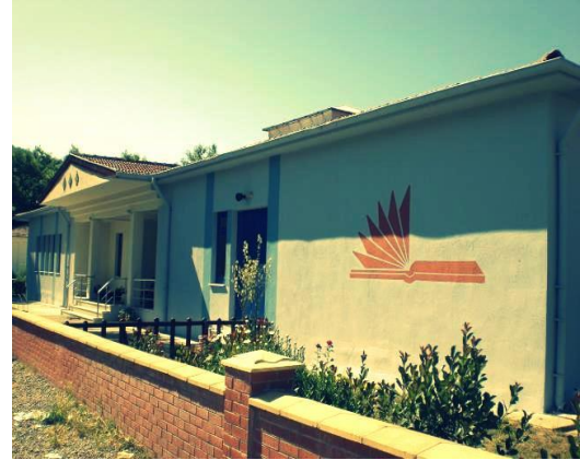
(37) Kütüphane Dış Duvar Süslemesi
